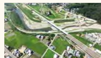
河川改修工事
