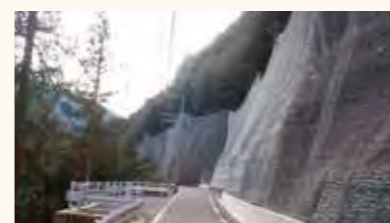
落石対策工事
