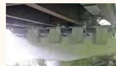
落橋防止工事
