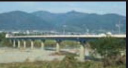
瀬詰大橋(昭和41年)
