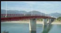
穴吹橋(平成3年)
