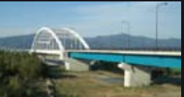
西条大橋(平成16年)
