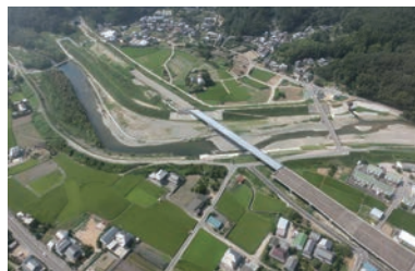
園瀬川(河川改修)
