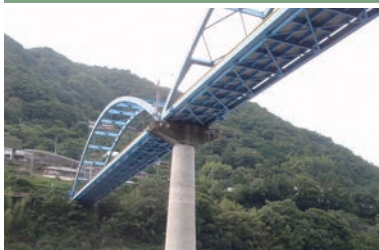
祖谷口橋(耐震補強)
