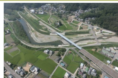
園瀬川(河川改修)
