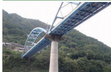
祖谷口橋(耐震補強)
